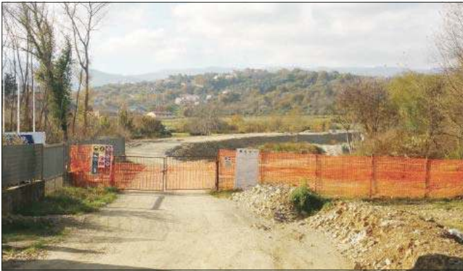
I lavori alla strada di Saporito
